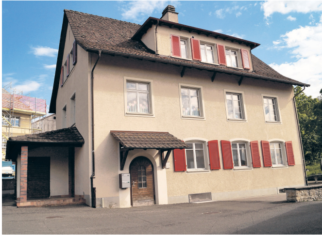
Das bestehende Schulhaus wird nur «pinselrenoviert», dagegen entsteht auf dem Sportplatz ein neuer Schulraum-Pavillon.
